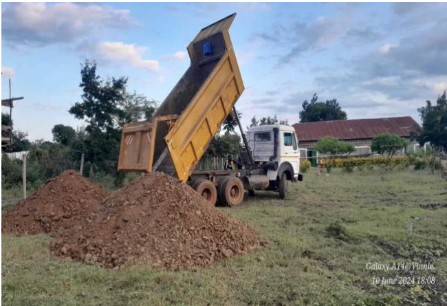
(놀이터 공사 현장)
