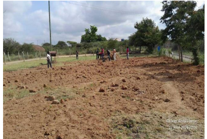
(놀이터 공사 현장-2)
